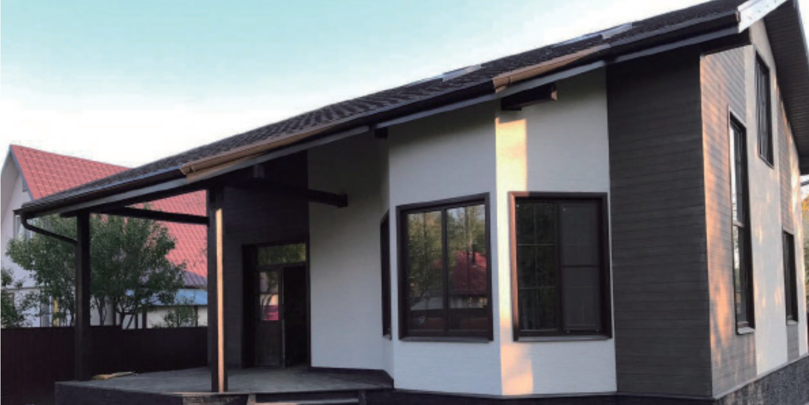
Частный дом Московская обл. NW4056U NW3752A NW3843A
